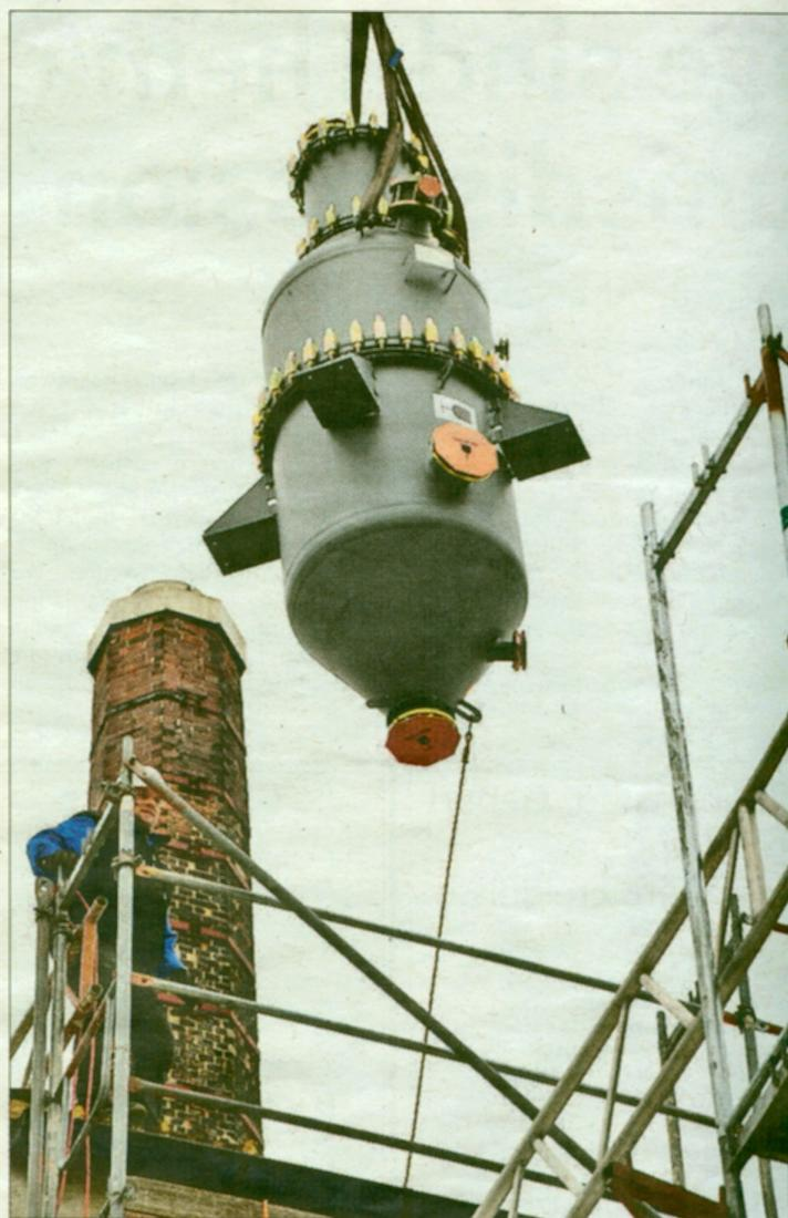
Maßarbeit: Ein Kran hievt den tonnenschweren Kristallisator durch das geöffnete Dach an seinen Platz.
